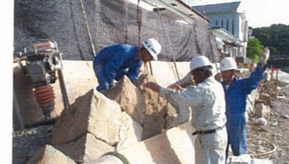
ベテラン石工による伝統的石積修復作業
