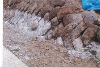
発掘後の石積護岸
