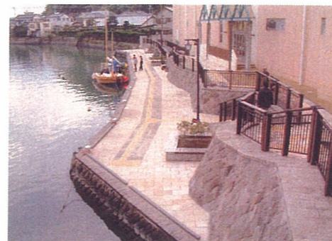
▲油津大橋下流右岸側完成区間(H10年度)
