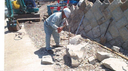
ベテラン石工による伝統的石積修復作業
