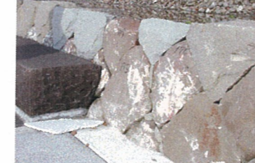
修復された石積護岸
